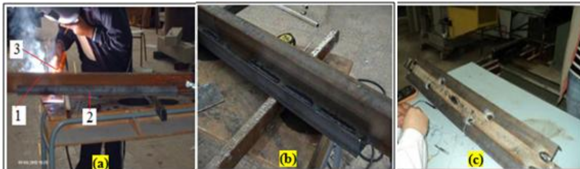
Figure 3. Opérations de soudure
